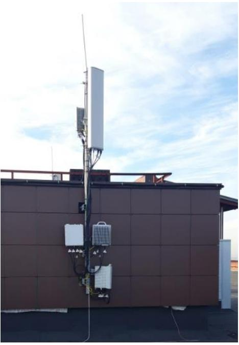
трубостойка на стене здания
