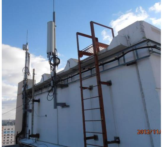
на стене лифтовой надстройки (крепление шпильками)
