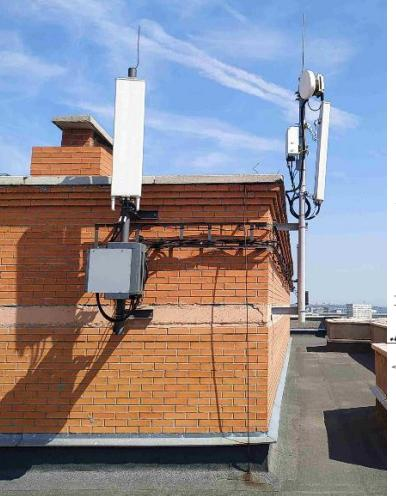
на стене лифтовой надстройки (крепление шпильками)
